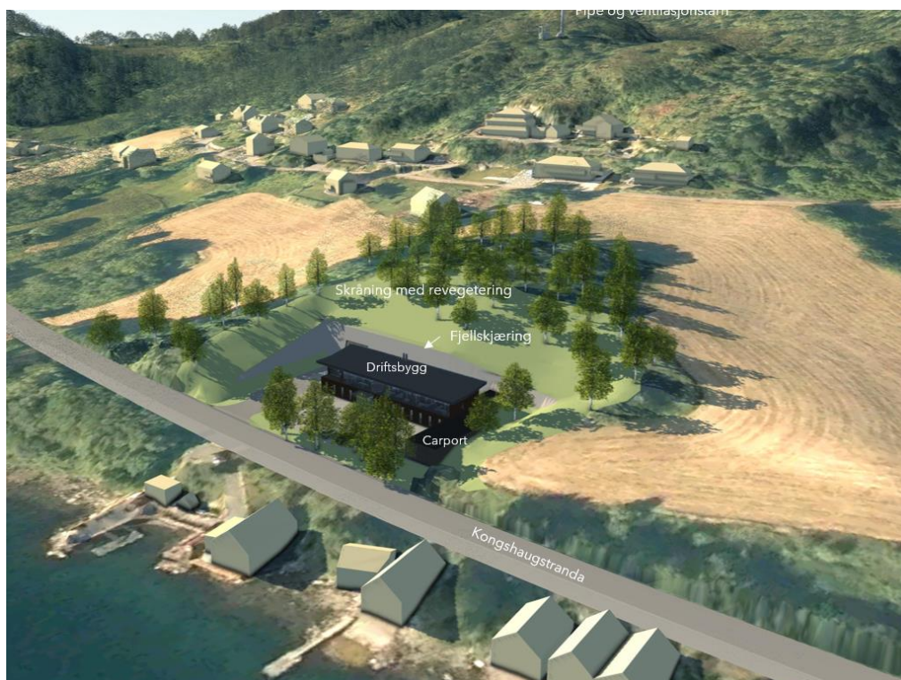
Figur 4-5: Oversiktsbilde som viser daganlegg ut mot Kongshaugstranda og pipe og luftinntak på åsen bak.
