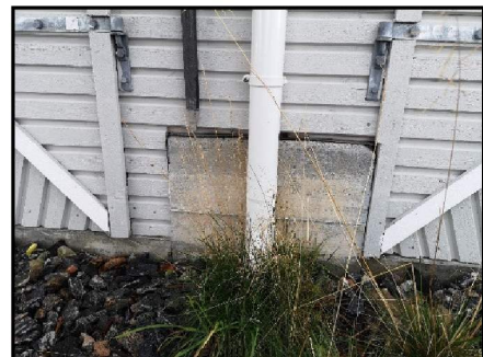
Foto viser fundament på ca 40 cm høyde i bygningskonstruksjonen
