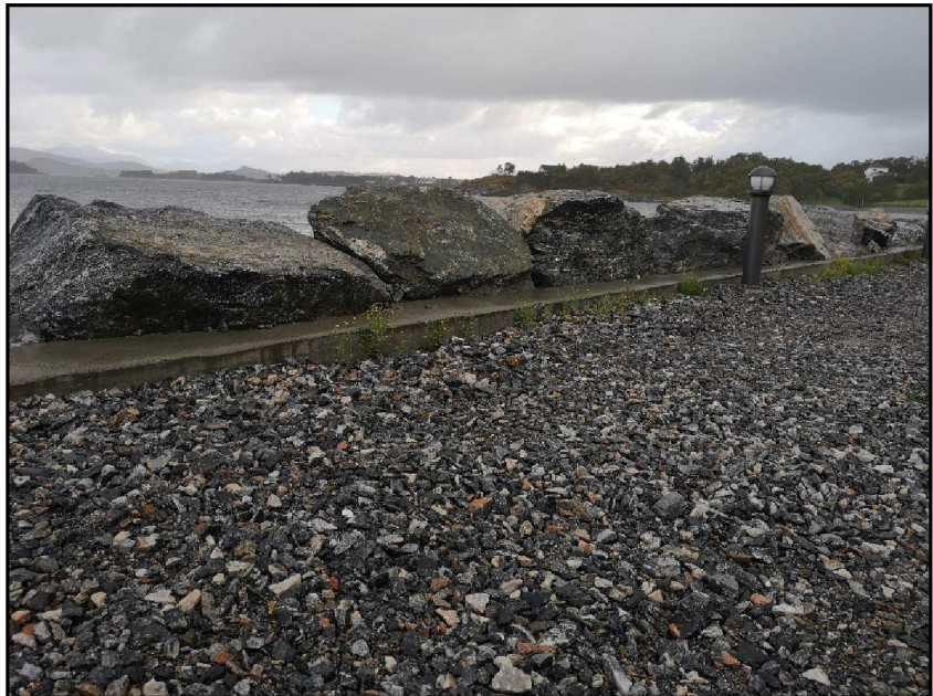
Foto viser etablert murkant mellom sjølinje og planert areal nord for bygningene, samt etablert stablet stein mellom sjø og murkant. Betongkanten bidrar til å gi økt stabilitet for den stablede steinen.
