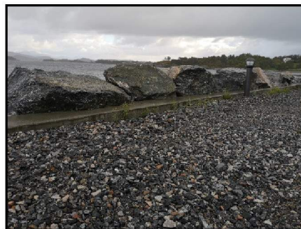
Foto viser stor stablet stein mellom planert terreng og sjøen.
