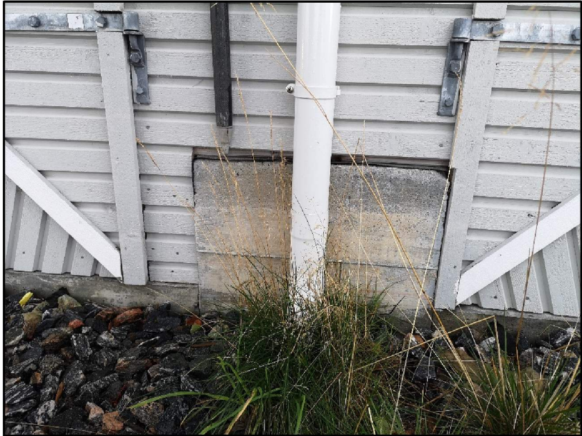
Foto viser detalj i sjøfasaden på eksisterende bygg, der betongfundament under bærende trekonstruksjon er bygget mellom naustene med ca 40 cm høyde.
