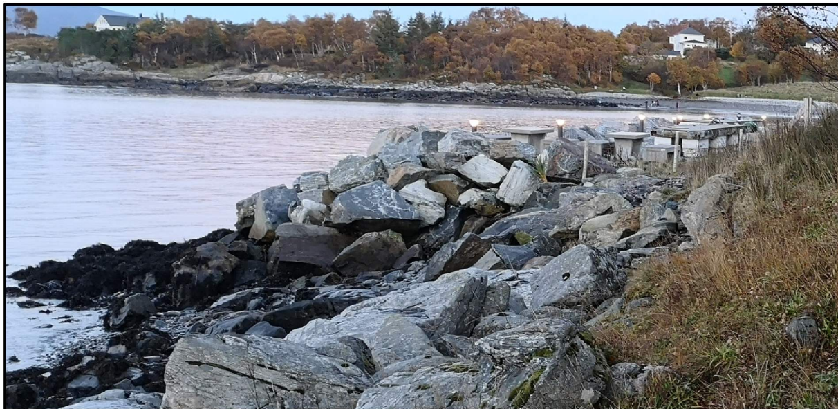
Foto viser etablert fylling med forhøyet steinkant mellom naust og sjø. Det planerte arealet nord for naustene har etablert belysning og betongbenker.
