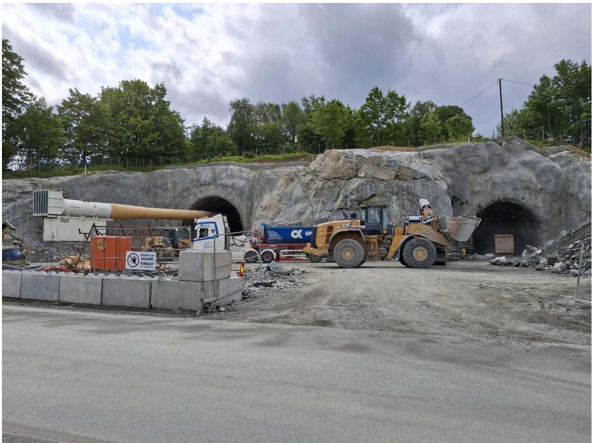
Figur 1 Arbeid foran tunnellinnløpet til Kongshaugen renseanlegg (bilde tatt 06.06.25)
