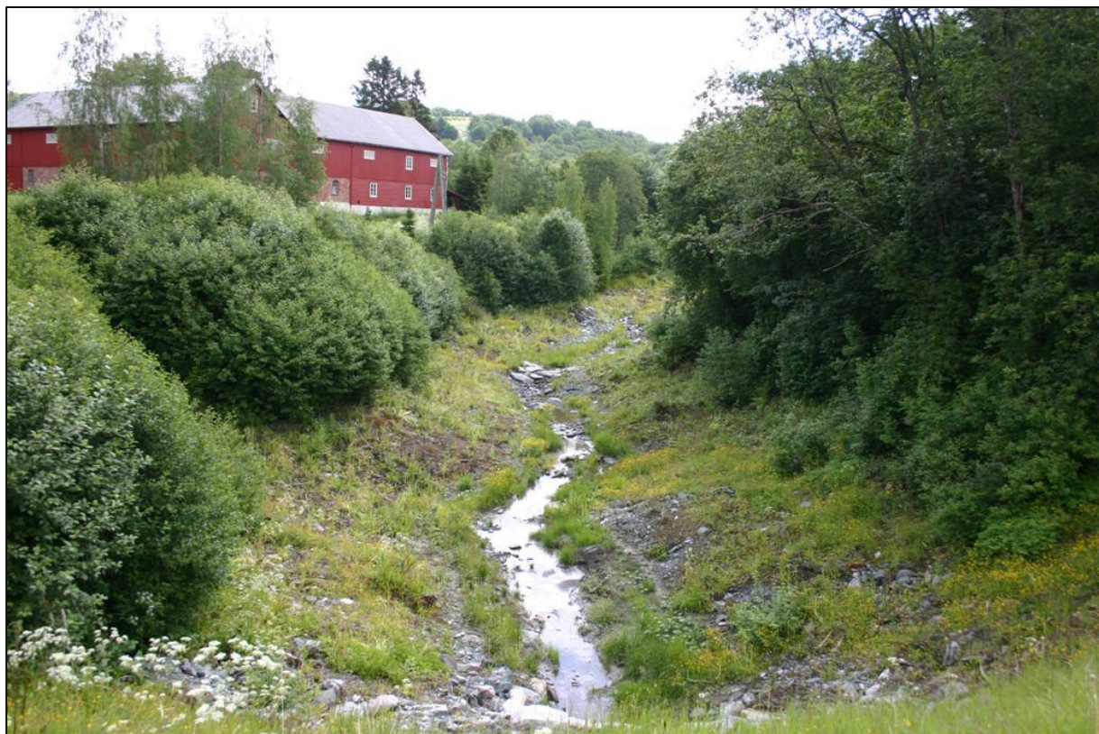
Figur 18: Valsetbekken i Skaun kommune er eit døme på ferdig erosjonssikra bekkeløp med ordna steinlag. Foto: Geir B. Hagen).
