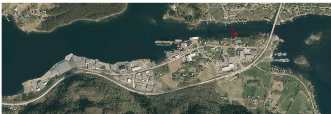
Figur 7: Flyfoto over området. Rød pil markerer området hvor nye naust er planlagt. Kilde: www.finn.no .
