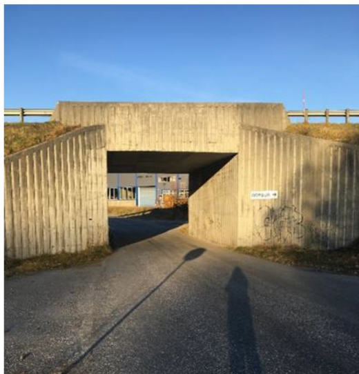
Figur 14: Kulvert under E39 på lokalvegen Kongshaugstranda.
