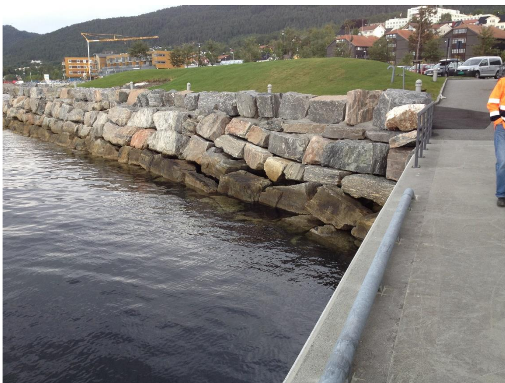
Figur 14 Promenade av murt og sprengt naturstein (Molde)
