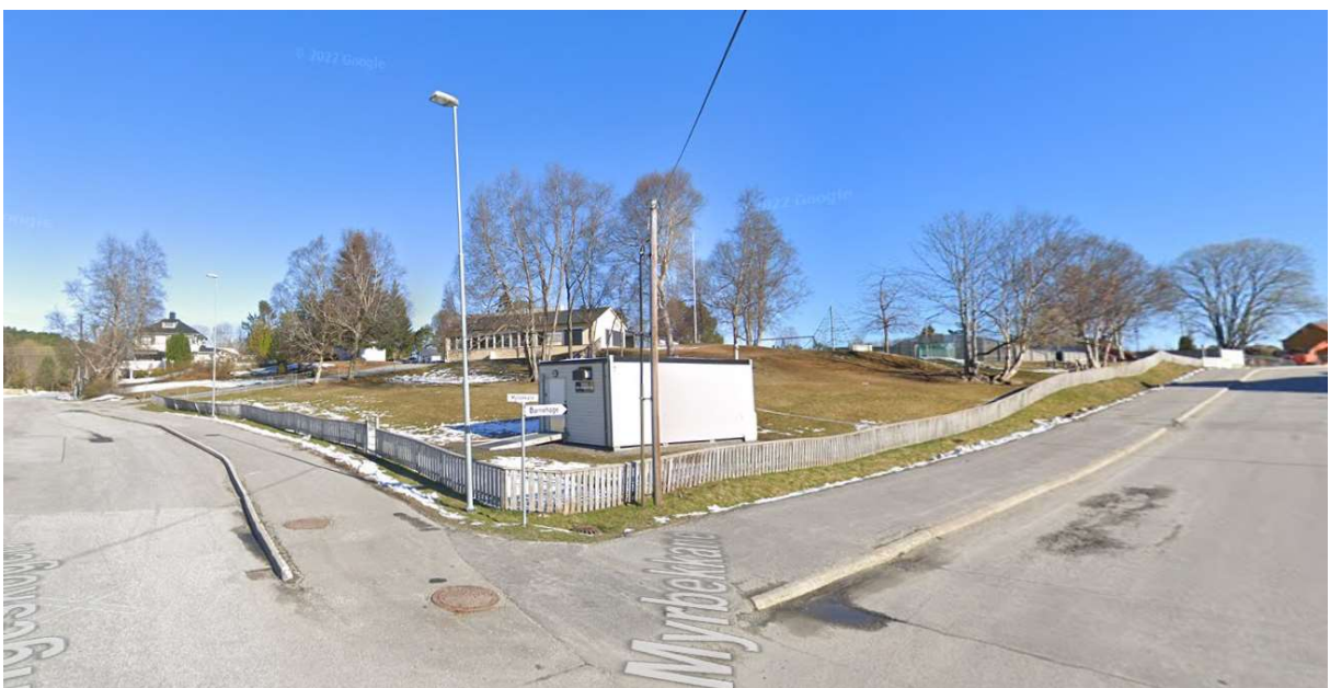
Planområdet sett fra sør, med frrområdet G6 og skolen på en høyde i bakgrunnen. Det er bygget fortau langs skuletomta. Google streetview, 2022
