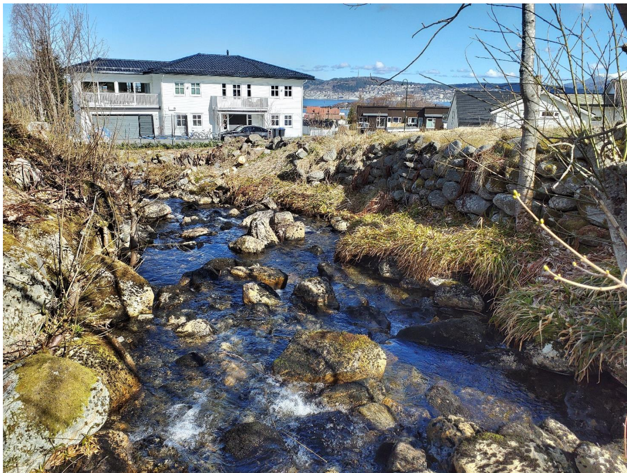
Figur 5: Opparbeidet erosjonssikring langs elveløp
