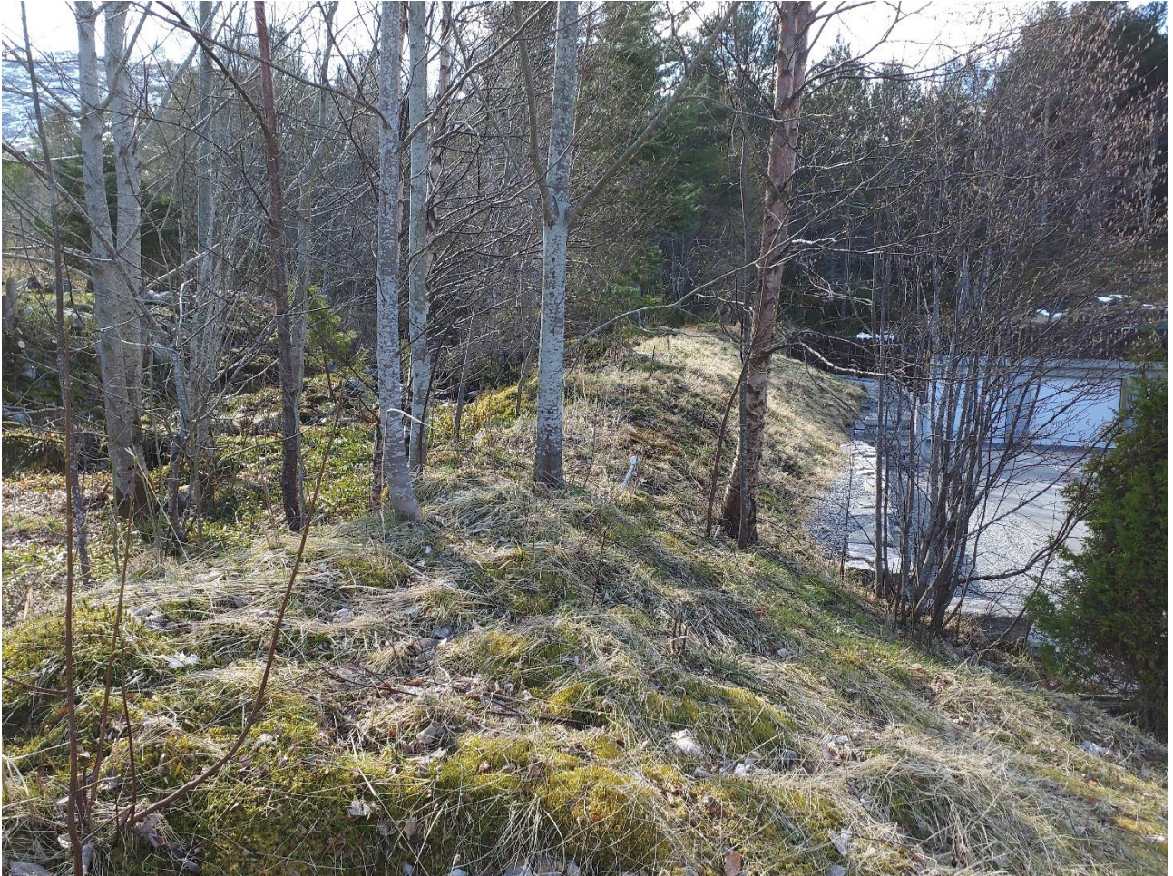
Figur 6: Sikringstiltak i form av voll som er etablert mellom elv og boligområde.
