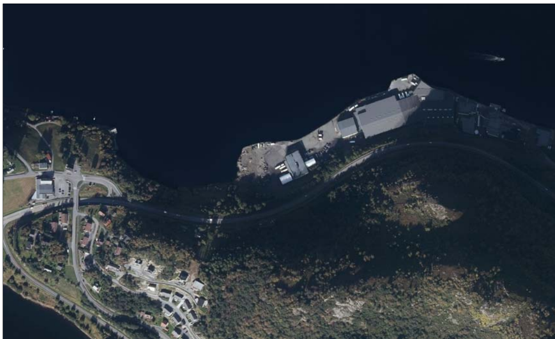
Eksisterende situasjon. Næringsområdet består av større lagerbygninger og trafikkareal. Kilde: Flyfoto, Sula kommune.
