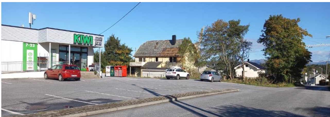
Figur 5. Planområdet sett frå Risevegen. Det gule bustadhuset er no rive, og trea til høgre i bildet er fjerna.
